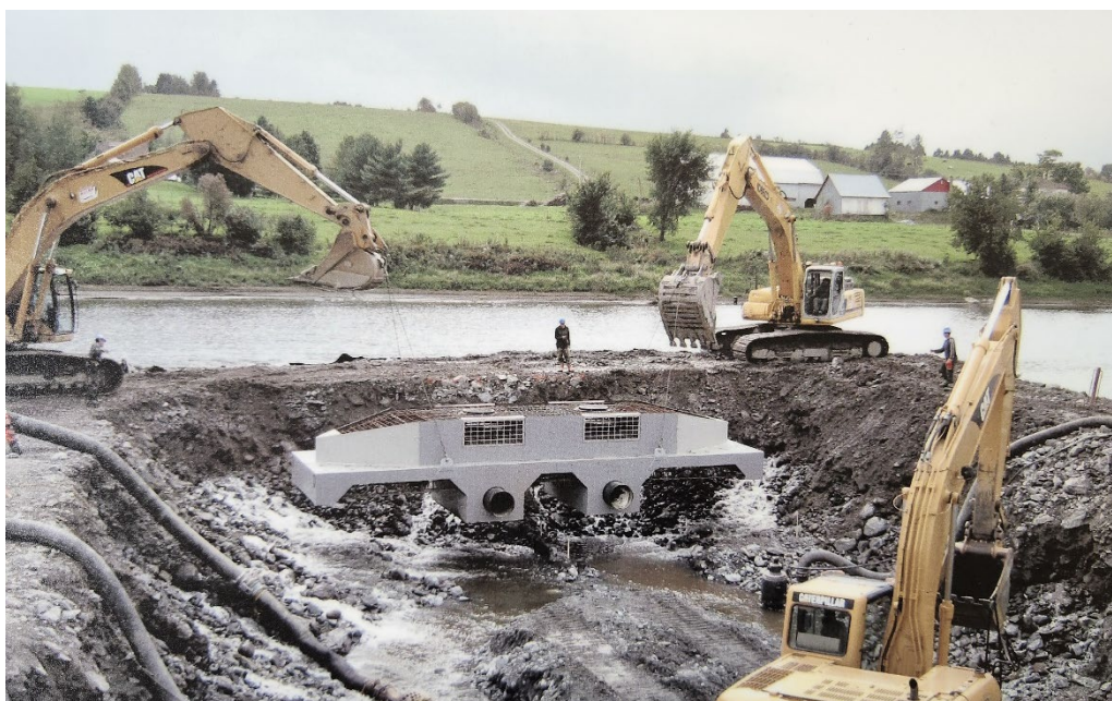
Photo 1 : Installation de la prise d'eau
